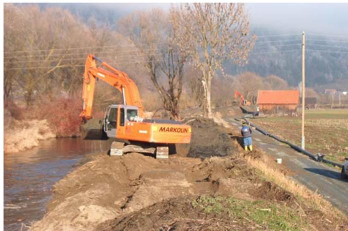
**Modul 2:** Im drainierten, landwirtschaftlich genutzten Poldergebiet zwischen dem östlichen Seeufer und der Bleistätter Moorstraße wird ein Vorsee entstehen, in den Drainagenwässer und Tiebelwasser dosiert eingeleitet werden. Das Flutungsbecken wird die Funktion eines Rückhaltebeckens für Trübstoffe und Nährstofffrachten der Tiebel einnehmen und somit den See entlasten.
